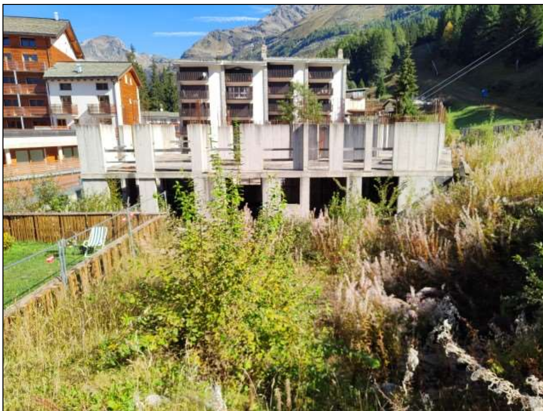
Foto n. 5 – Struttura in C.A. fuori terra
