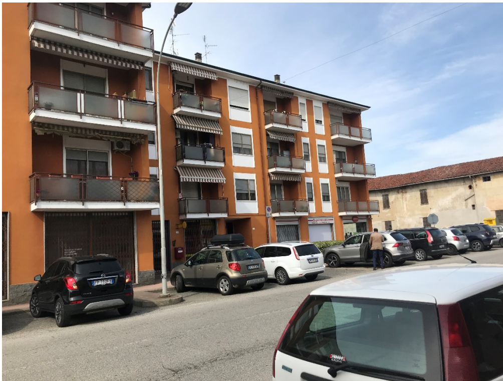
Foto n. 2: Prospetto principale su Via Umberto I
