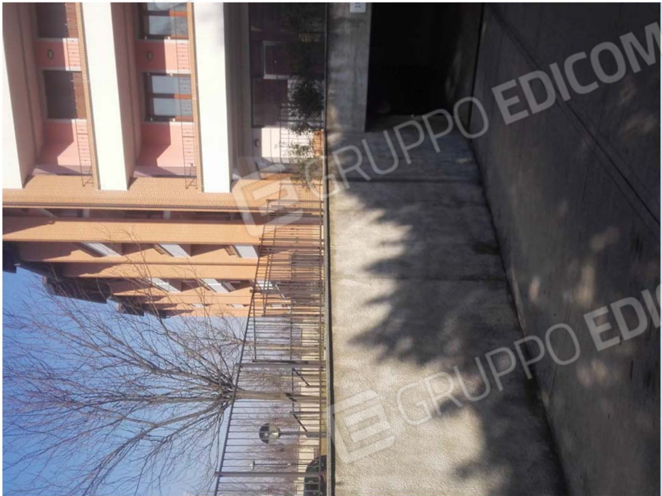
Zona comune autorimessa (4)
