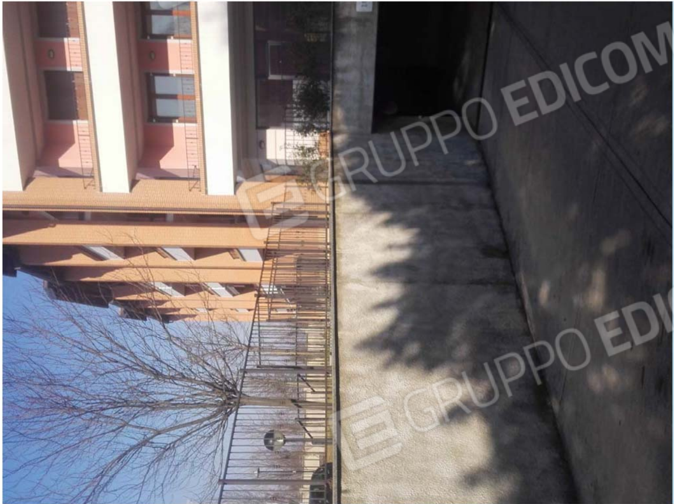
Zona comune autorimessa (4)
