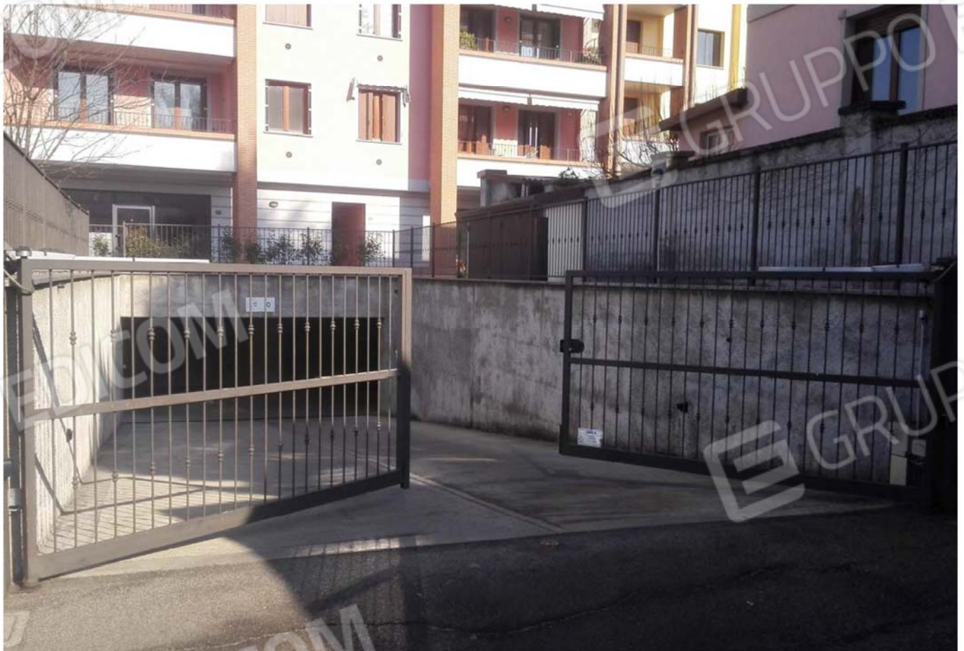
Zona comune autorimessa (5)
