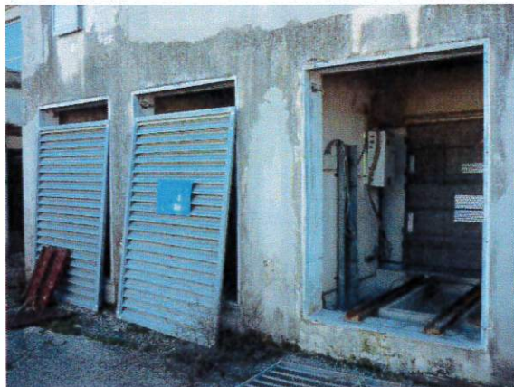
Qui sopra e nelle ultime foto della pagina precedente, rappresentazione di alcune delle devastazioni e/o danneggiamenti vandalici in atto nella struttura, volta all'asportazione di alcuni componenti.
