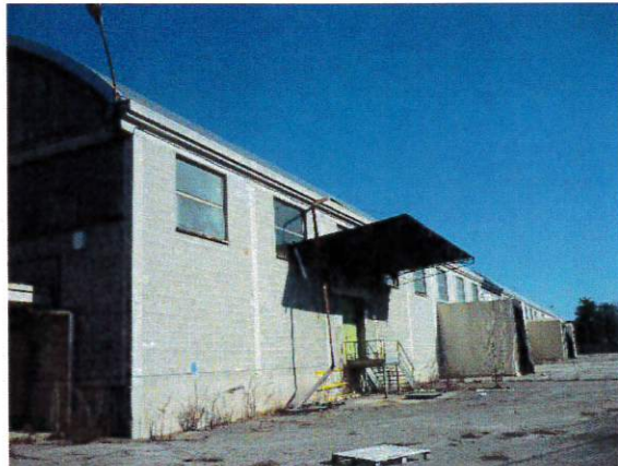
Ultime due foto della pagina precedente e qui sopra: il primo tratto del fianco a Sud-Ovest che, dopo il dado direzionale rivestito in klinker, vede i primi capannoni a volta centinata, con le lastre in amianto-cemento della copertura, incapsulate e rivestite con lamiera corrugata in alluminio. Si intravedono anche alcune baie di carico-scarico, alternate a delle rampe per l'accesso dei carrelli elevatori ed una pesa per automezzi.
