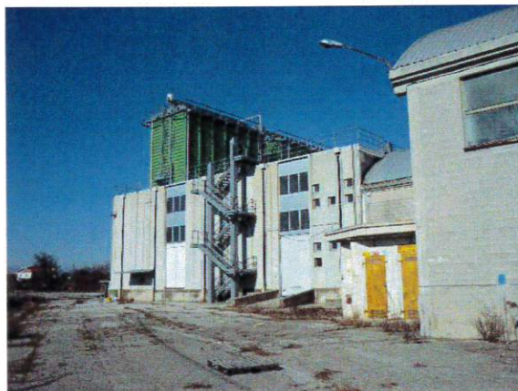
Ultime due foto della pagina precedente e qui sopra: il primo tratto del fianco a Sud-Ovest che, dopo il dado direzionale rivestito in klinker, vede i primi capannoni a volta centinata, con le lastre in amianto-cemento della copertura, incapsulate e rivestite con lamiera corrugata in alluminio. Si intravedono anche alcune baie di carico-scarico, alternate a delle rampe per l'accesso dei carrelli elevatori ed una pesa per automezzi.
