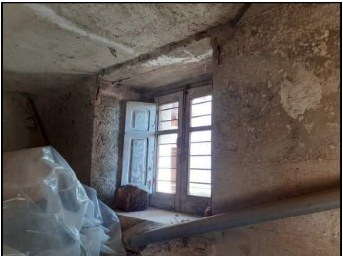
Foto 24. Muro lato est con finestra locale cantina
