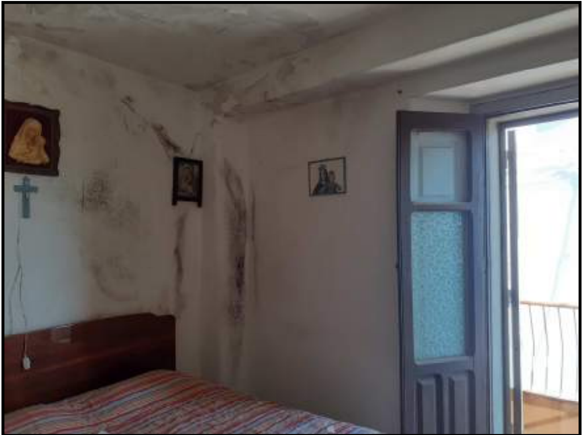
Foto 11. Vista pareti e soffitto piano primo
