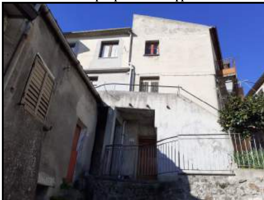
Foto 4. Vista prospetto lato sud di ingresso appartamento
