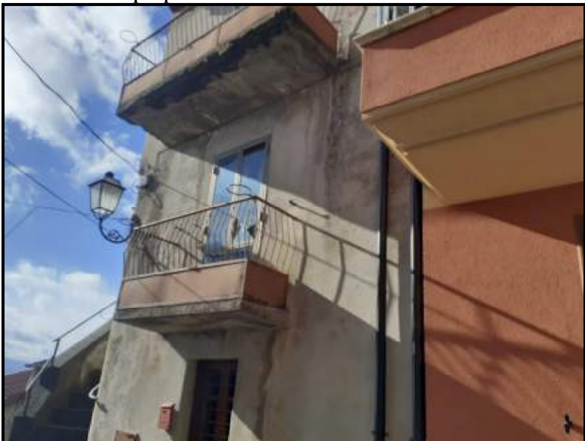
Foto 6. Vista solette balconi prospetto est
