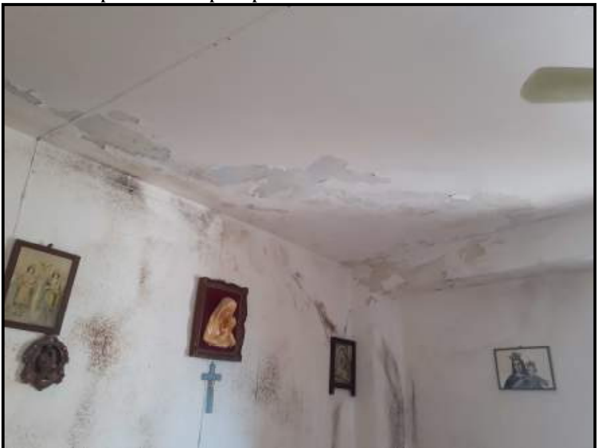
Foto 12. Altra vista pareti e soffitto piano primo
