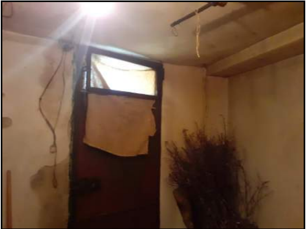
Foto 31. Ingresso cantina al civico 15
