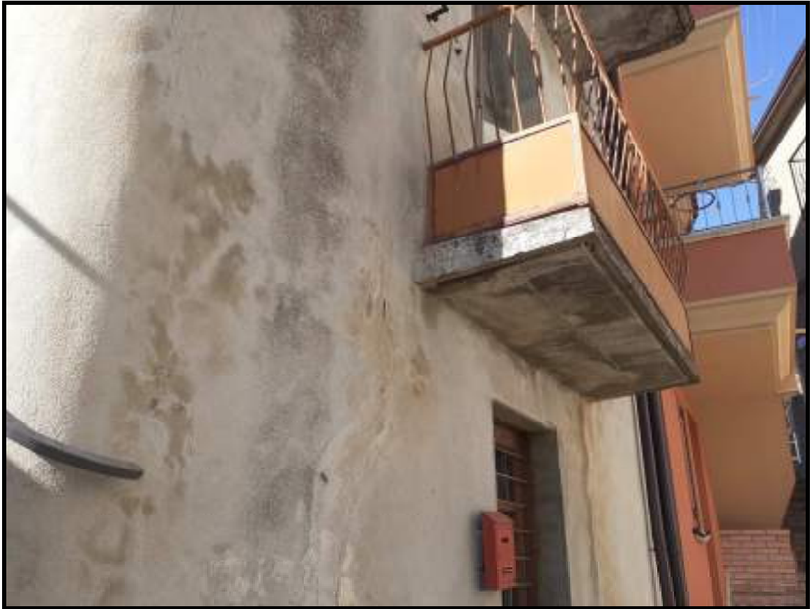
Foto 5. Particolare prospetto est
