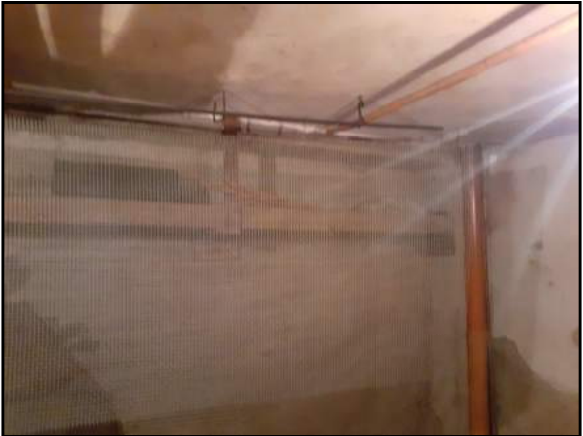
Foto 33. Vista altre pareti e soffitto
