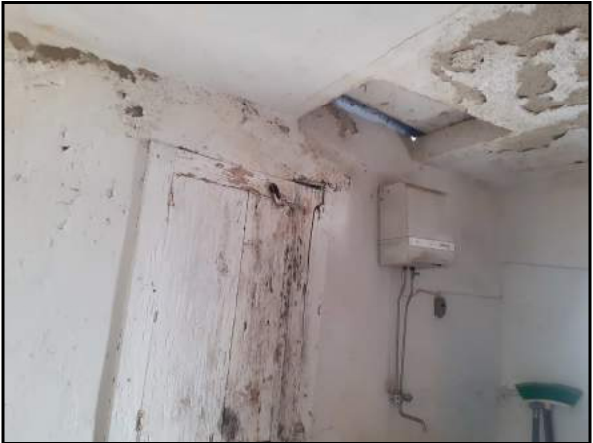
Foto 29. Pareti e soffitto civico 17
