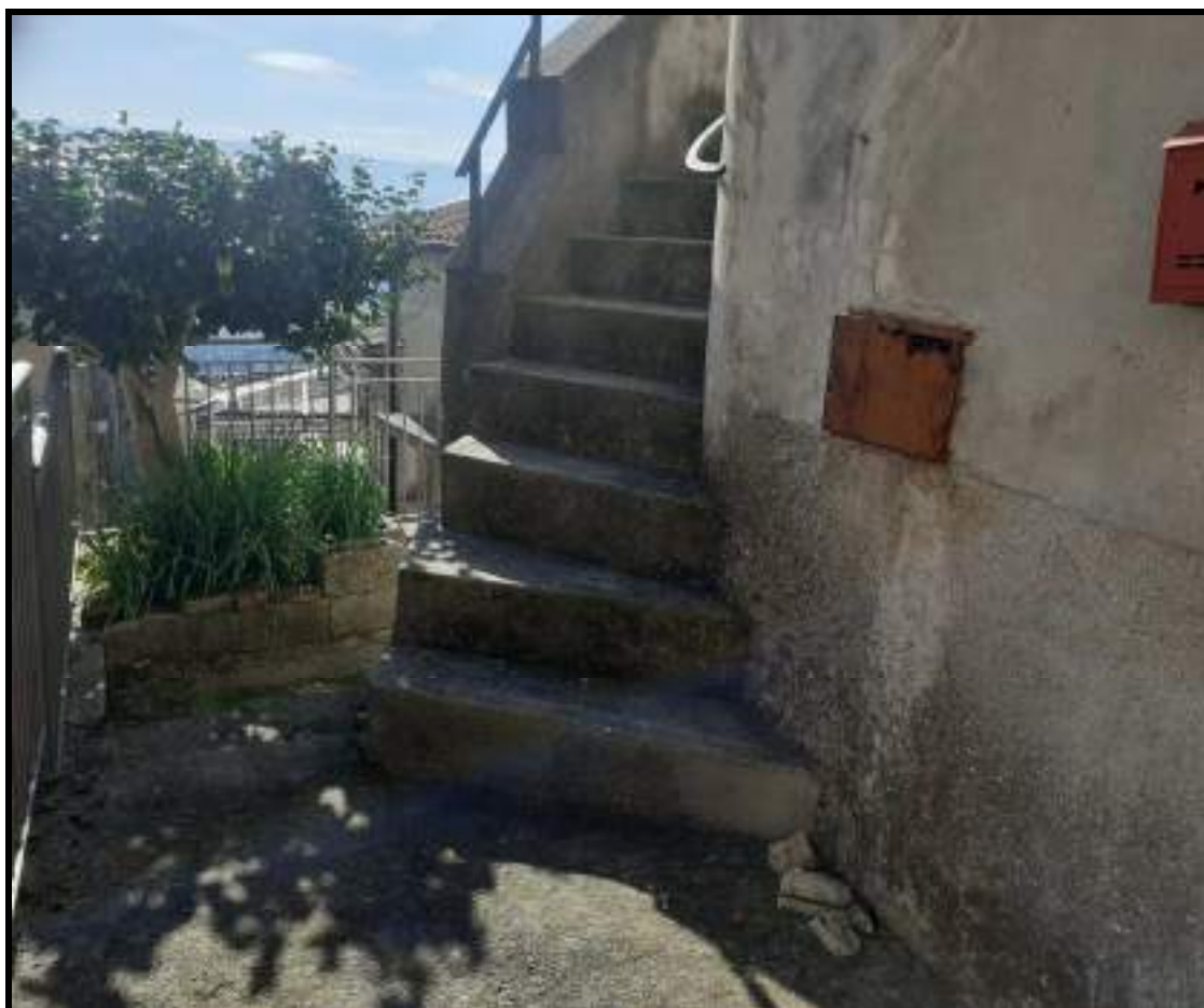
Foto 7. Scala di accesso ad appartamento
