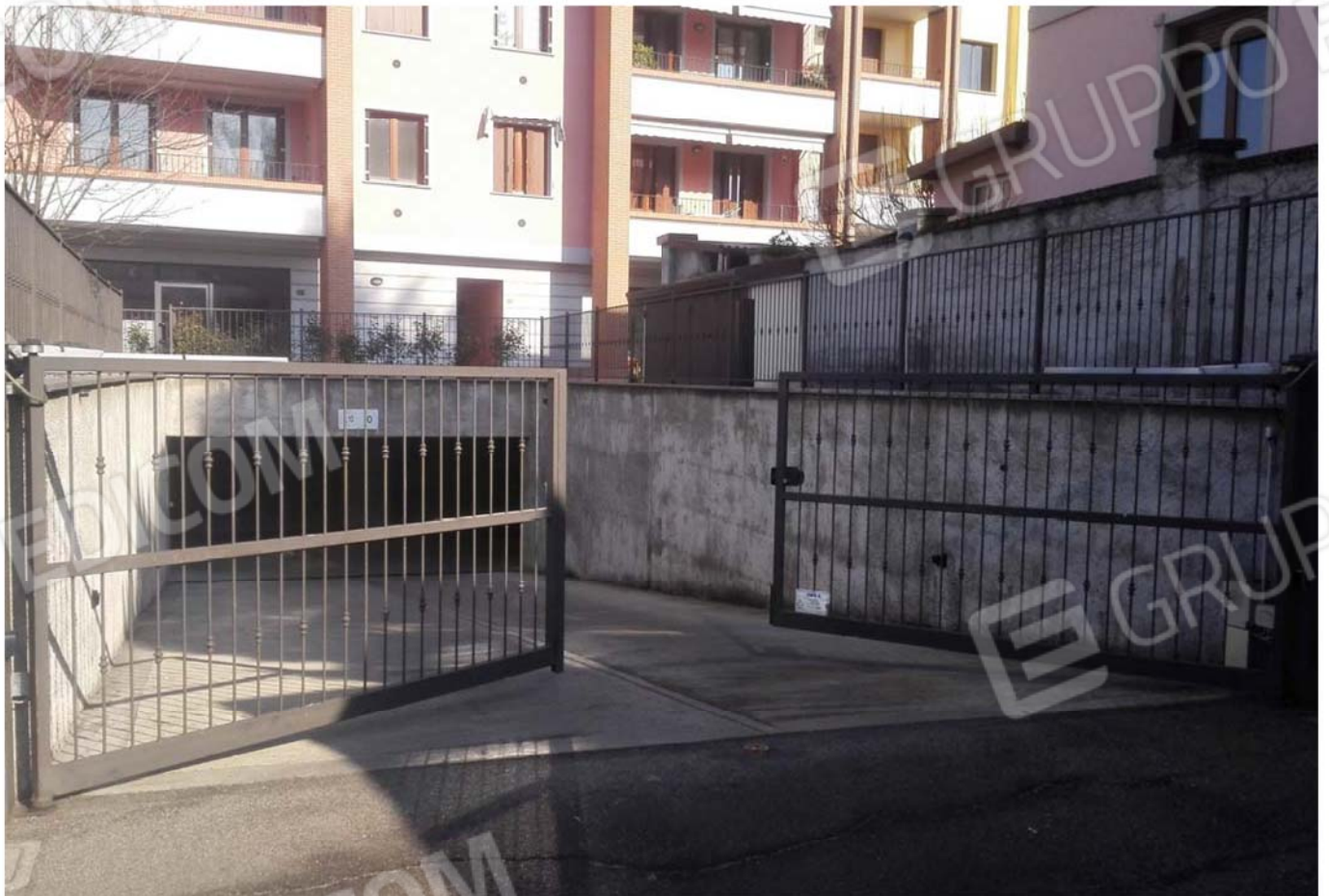
Zona comune autorimessa (5)
