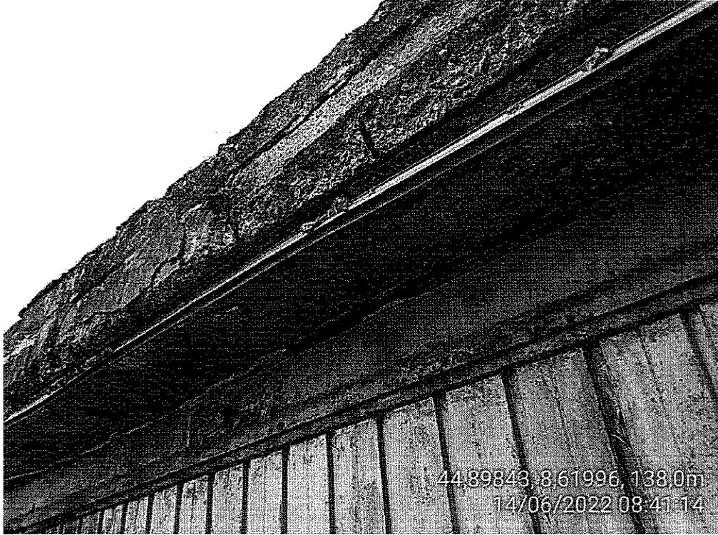
*Sfaldamento soletta con esposizione ferri armatura*
