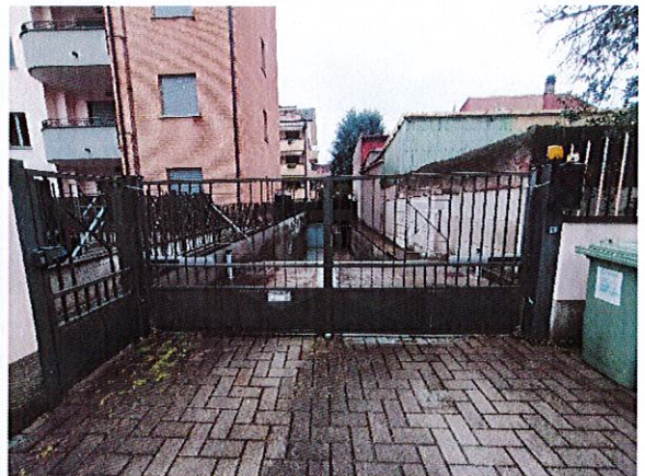
Ingresso carraio dell'edificio
