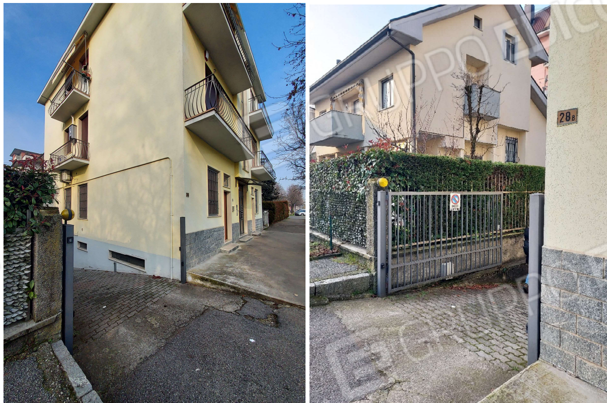
Vista da Via Quintino di Vona
