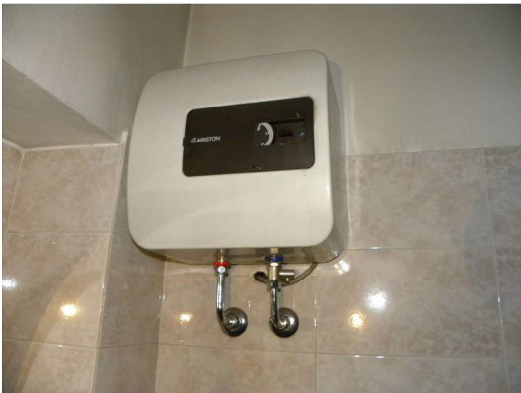
Dettaglio bollitore elettrico ad accumulo
