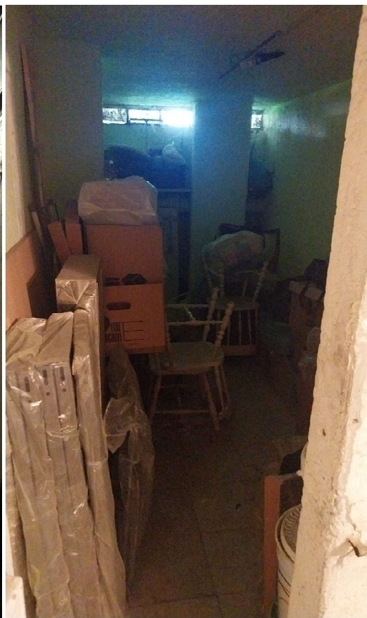
Foto nn. 20-21-22-23. Piano Seminterrato. Cantina
